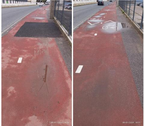
vii) Pk 1+935 a 1+940, aproximadamente: a A.R. – Águas do Ribatejo, E.I.M., S.A., procedeu à reparação de rotura em conduta disposta sob a ciclovia, colocando betão betuminoso diferente ao aplicado na ciclovia (AC 14, mais rugoso e com mais vazios de agregados), não aplicando a pintura em *slurry* sintético à cor vermelho (tal como aconteceu na situação anterior);
