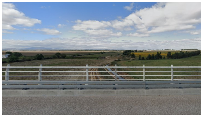
Fotografia 3: Vista da A10/IC11 para o Canal do Sorraia no limite sudoeste da UE
