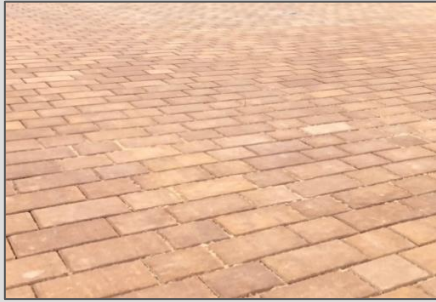
Pavimento em blocos de betão do tipo Artebel, Românico cor camurça.
