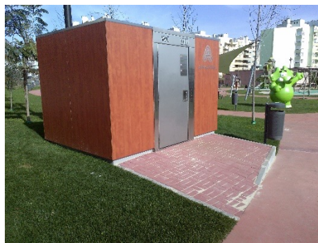
Fornecimento e colocação de instalação sanitária do tipo "Soinca, W.C. L200 modelo Essencial, ou equivalente
