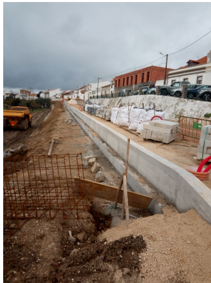
Execução de muro de suporte para passeio
