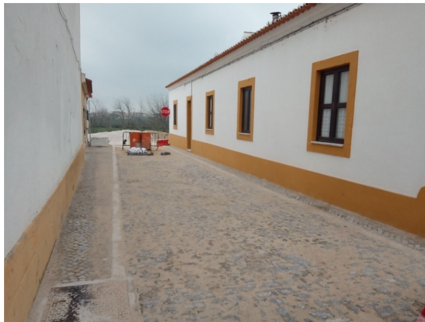
Pavimentação Rua Fernando de Oliveira
