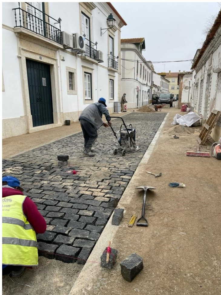
Pavimentação zona da biblioteca - Rua Fernando de Oliveira
