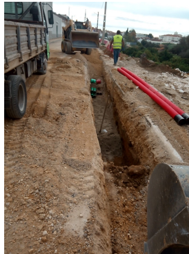
Execução de infraestruturas
