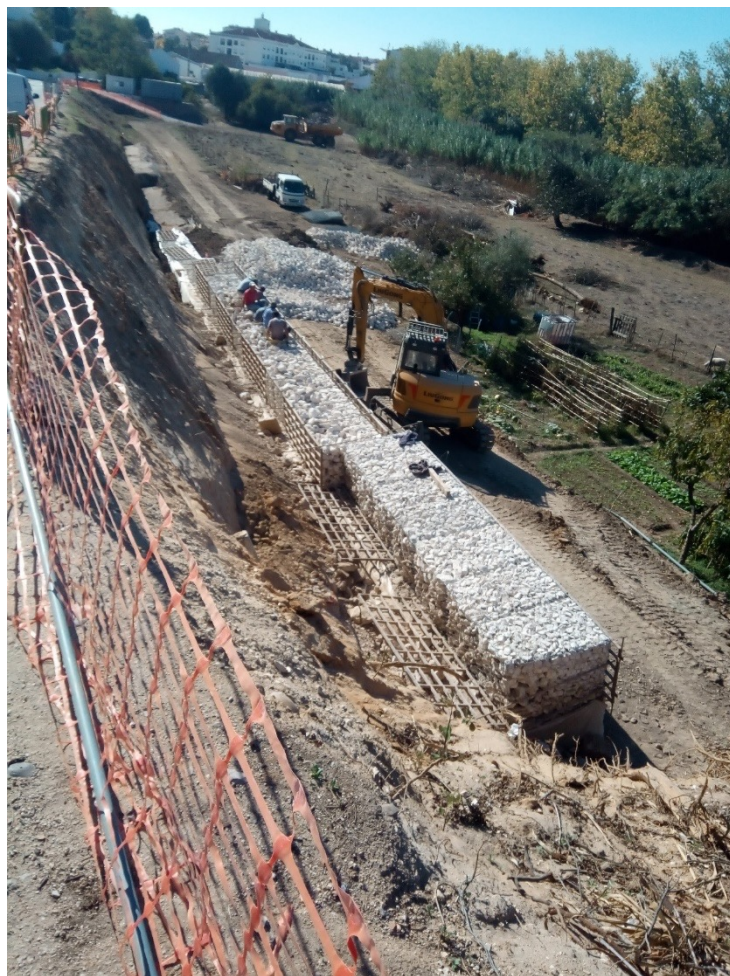
Execução de muros de suporte em gabião
