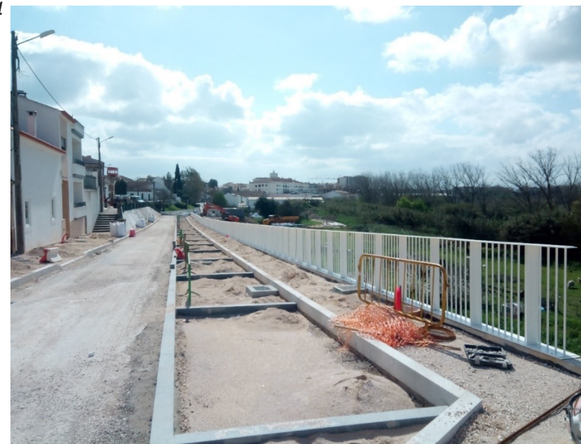
Avenida das Acácias – Gradeamento, lancilagem para estacionamento e passeio
