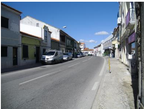
Figura 12 – Rua Luís de Camões. Troço da EN 118
