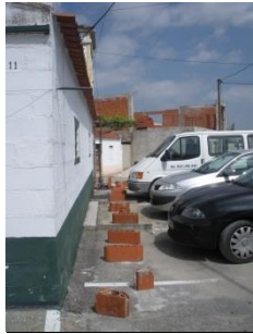
Figura 28 - Marcação de lugares de estacionamento mal executada.
