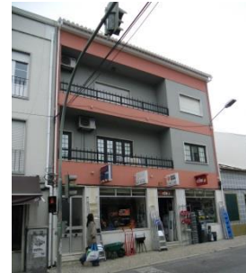
Figura 3 – Exemplo de Edifício Dissonante
