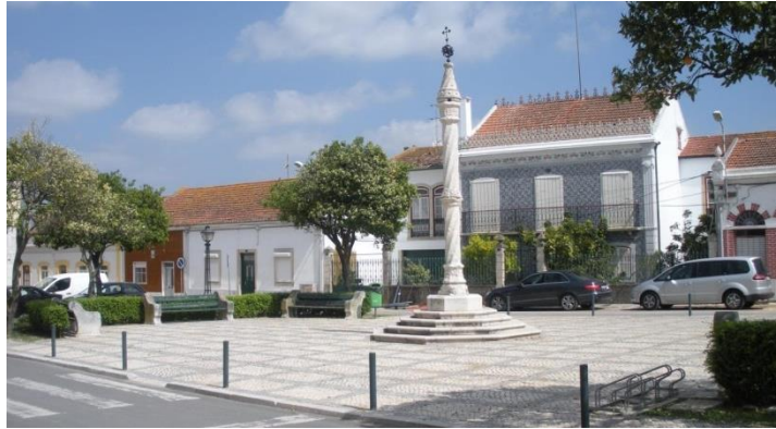
Figura 18 - Praça do Município – espaço exterior em bom estado de conservação
