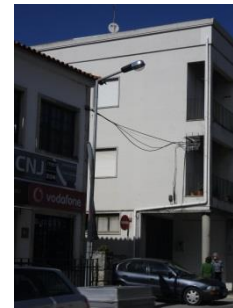
Figura 11 - Tipologia para iluminação pública. Rua Luís de Camões
